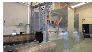
Avec la technologie CRS, Reciclaia a mis au point un procédé thermique pour séparer les résines des fibres. Photo : © Constrictor
