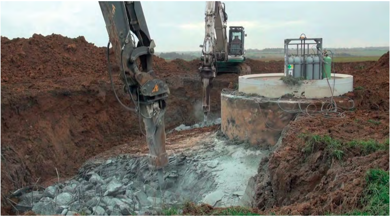
Photo 4 – Démantèlement d'une fondation d'éolienne à Criel-sur-Mer (76).
