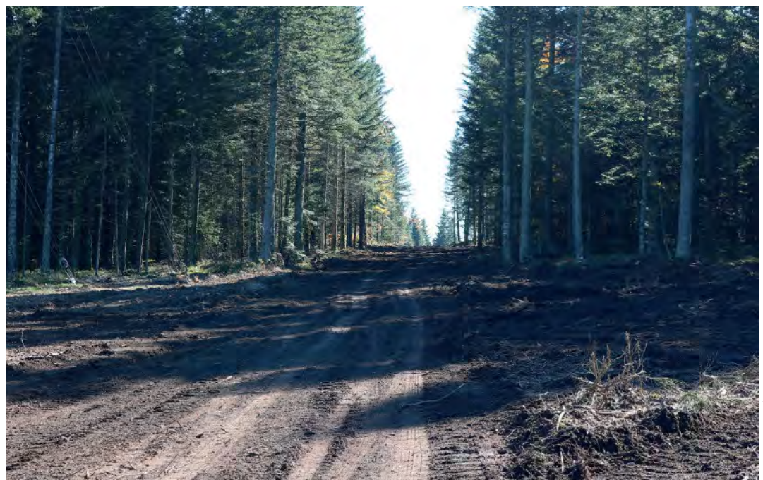
Photo 5 – Défrichage pour l'établissement des voies d'accès d'un parc éolien. L'implantation d'un parc en forêt implique de gros travaux de défrichage et provoque donc l'ouverture du milieu, favorable à de nombreuses espèces de chiroptères.
