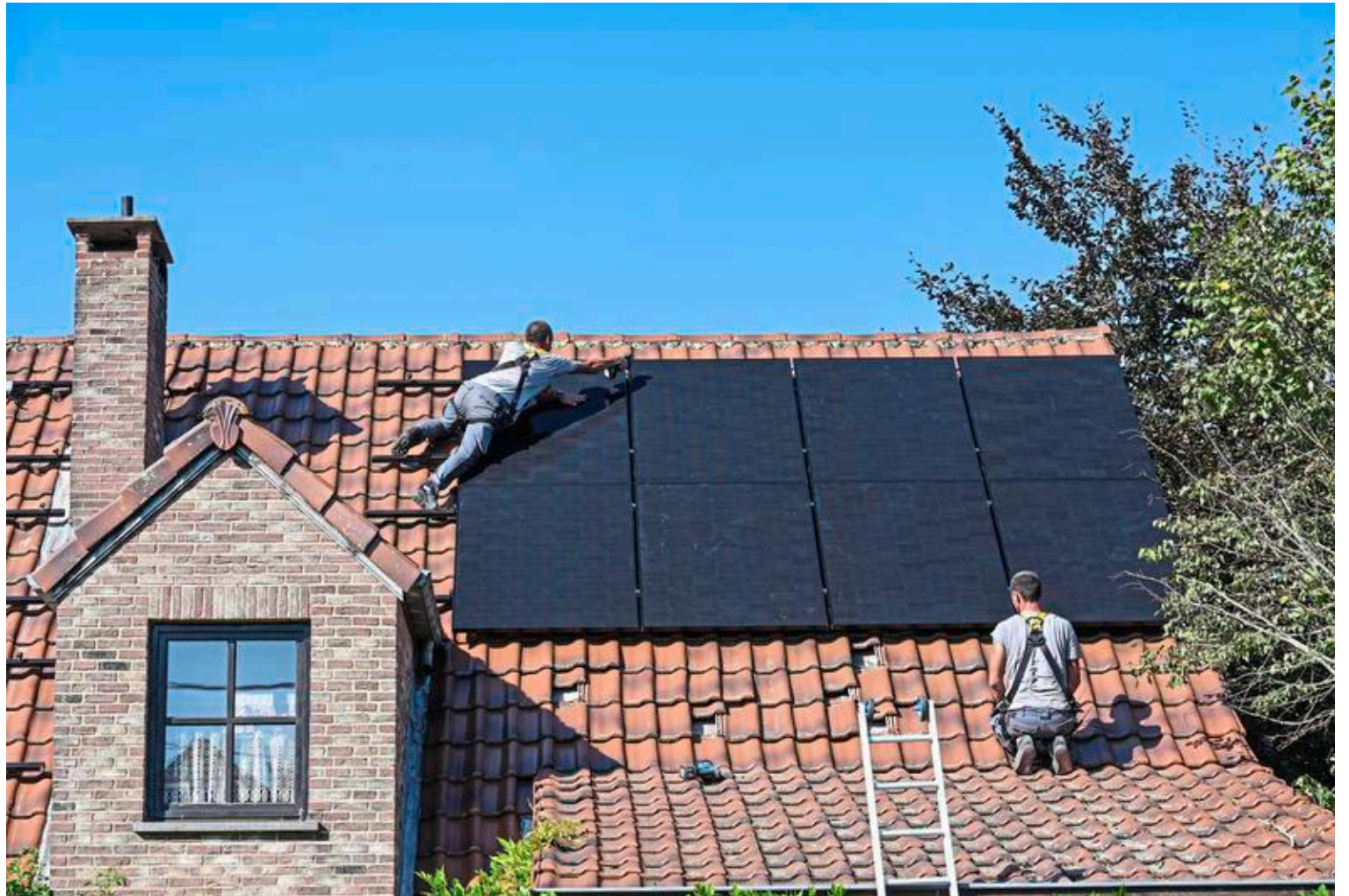
Chez un particulier, le 8 septembre 2021. En 2024, EDF a dû baisser la production de ses réacteurs face à l'afflux de courant d'origine photovoltaïque. Jean-Luc Flémal/Belpress/MaxPPP
