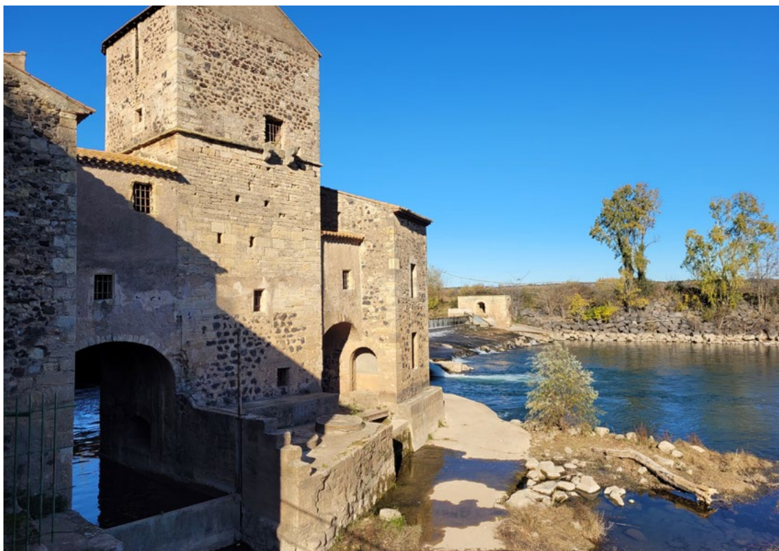
Centrale hydroélectrique du Moulin de Saint-Thibéry sur l'Hérault (Hérault).
