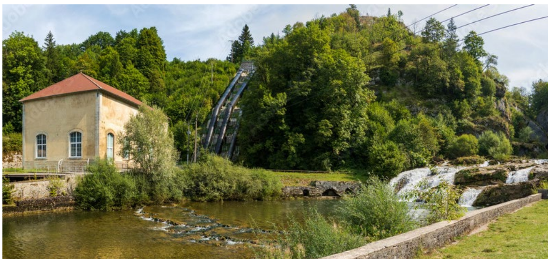
Cascades et centrale hydroélectrique des Pertes de l'Ain à Bourg-de-Sirod (Jura).
