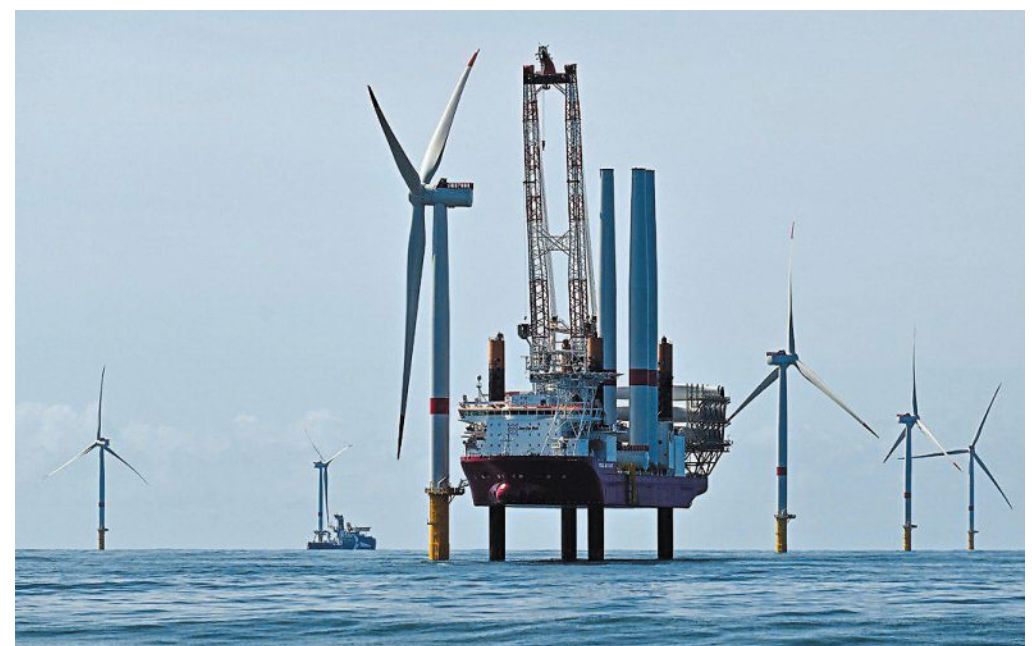
Le parc éolien en mer offshore des îles d'Yeu et de Noirmoutier en construction mi-février 2026. | PHOTO : FRANCK DUBRAY, OUEST FRANCE
