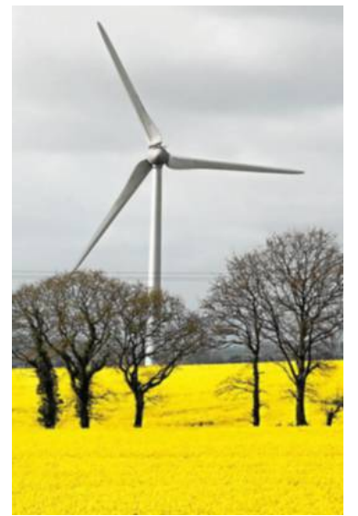
La remotorisation permet, en moyenne, de doubler voire tripler la production d'énergie. Photo Lionel Le Saux
