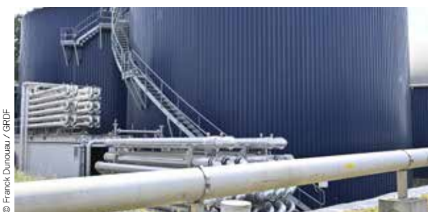
Site de méthanisation à Château-Gontier (53)
