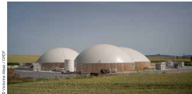
Site de méthanisation à Puisieulx (51)
