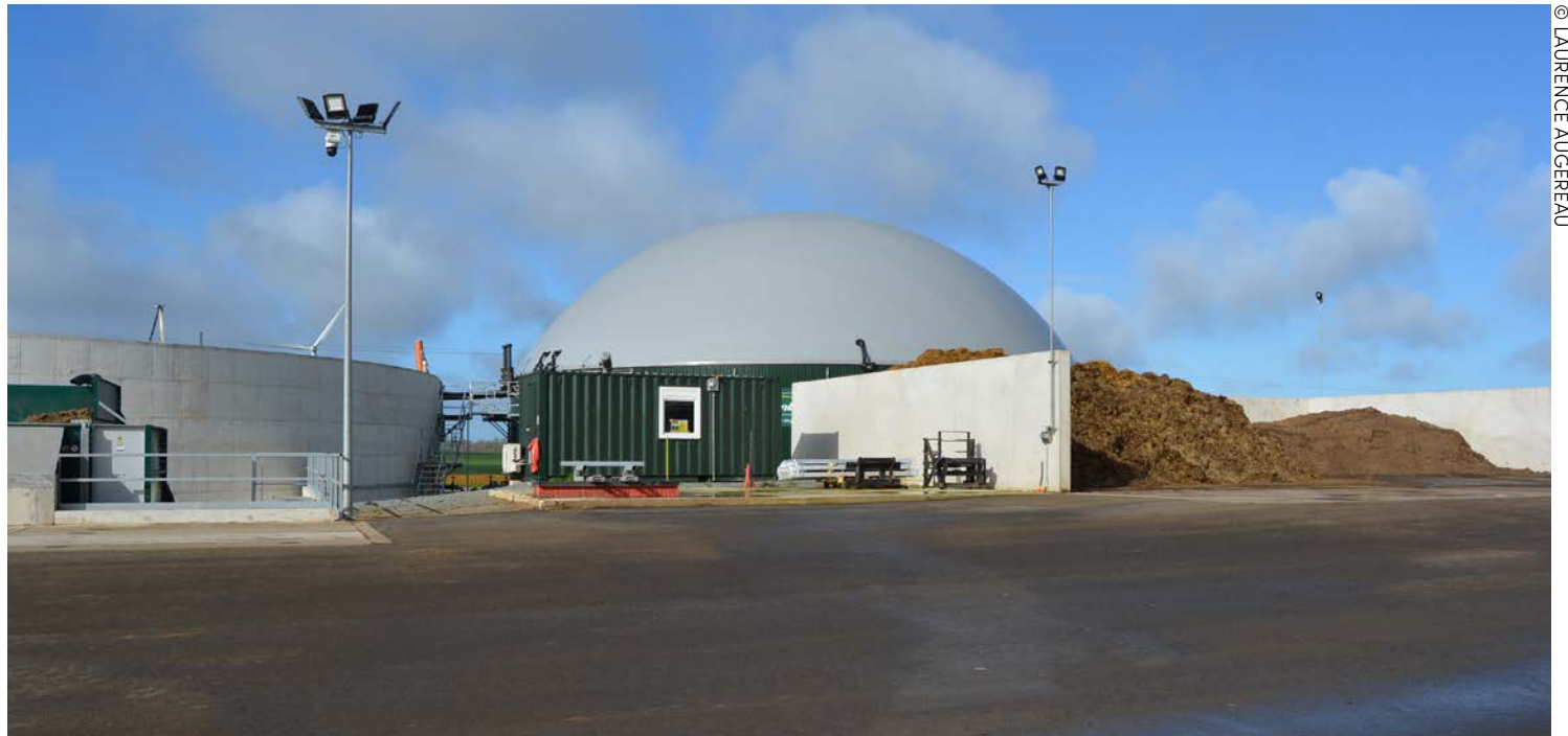
Dans de nombreux territoires ruraux, l'éloignement des infrastructures constitue un frein majeur à l'injection de biométhane dans le réseau gazier.
