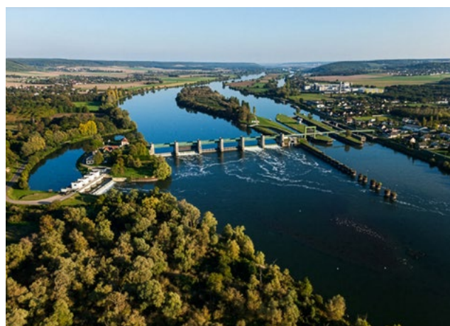
Centrale hydroélectrique de Port-Mort (27). Crédit photo : Francis Cormon
