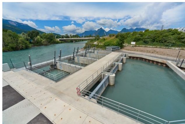
Vue en rive opposée à la centrale en turbinage Crédit photo : EDF / Dominique Guillaudin
