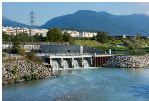
Aval de la centrale hydraulique du Rondeau sur la rivière Le Drac Crédit photo : EDF / Dominique Guillaudin
