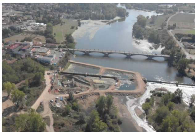
Vue du barrage en phase chantier avec la mise en place du batardeau crédit photo : SHEMA
