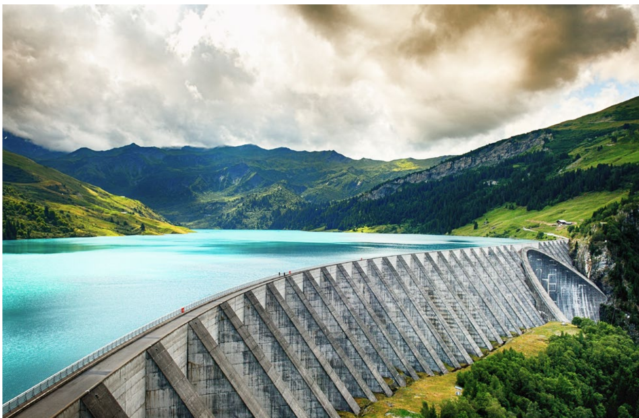
Barrage de Roselend (Savoie). Crédit photo : iStock / Vent du Sud
