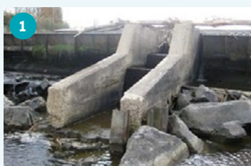
Passé à poisson datant de la construction du barrage (années 60)
