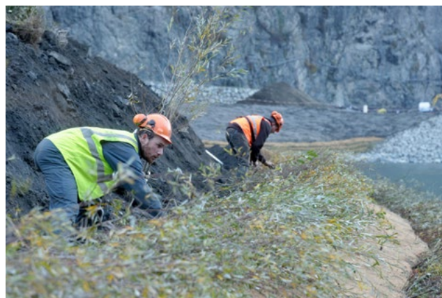
Les berges de la Romanche renaturées en « végétal local » Crédit photo : EDF / Christophe Huret
