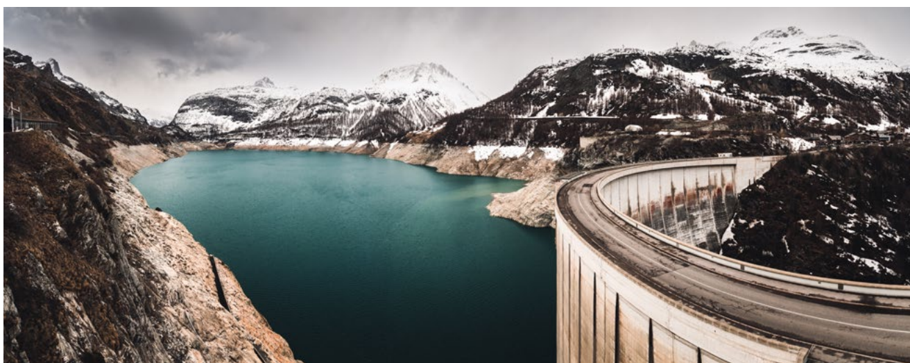
Barrage du Chevril sur l'Isère, Tignes (Savoie). Crédit photo : iStock / Grégory DUBUS
