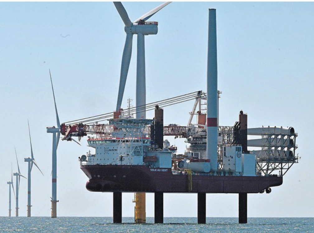
Ici, lors des travaux du parc de Yeu-Noirmoutier. | PHOTO : JÉRÔME FOUQUET, OUEST-FRANCE
