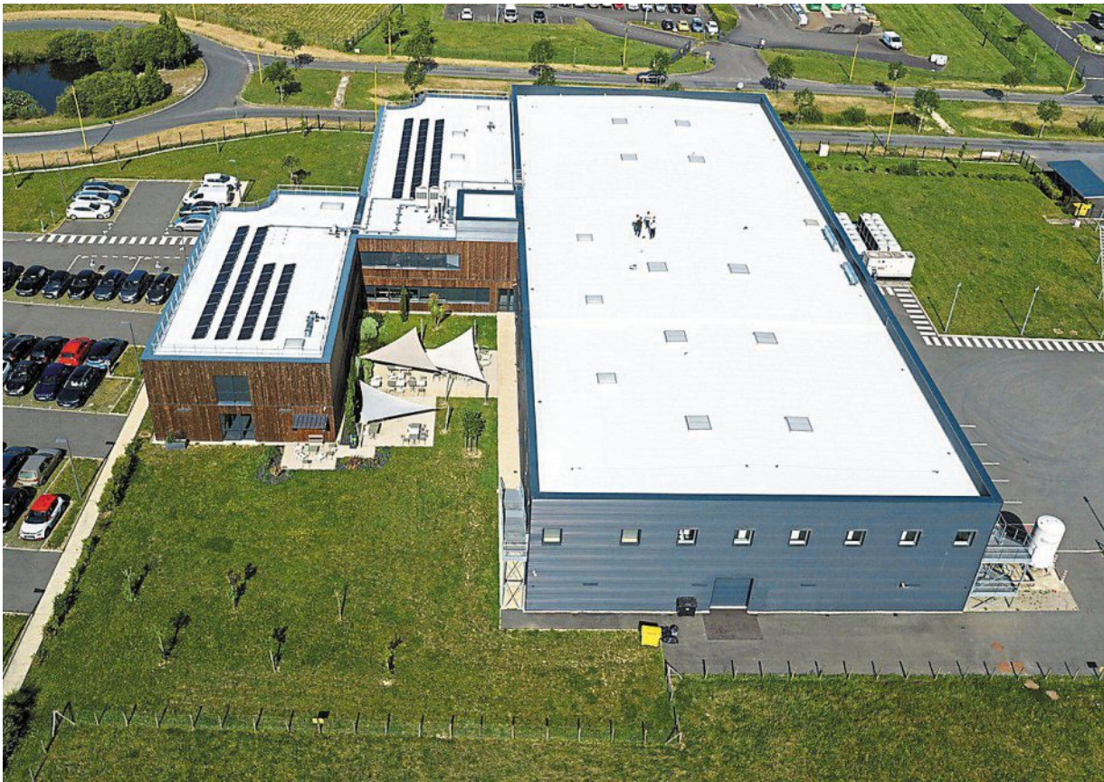
La société Clean Cells basée à Montaigu (Vendée) a confié aux entreprises Oktane et Enercool le soin de peindre en blanc le toit de l’établissement afin de faire des économies lors des épisodes de canicule. | PHOTO : FRANCK DUBRAY, OUEST FRANCE
