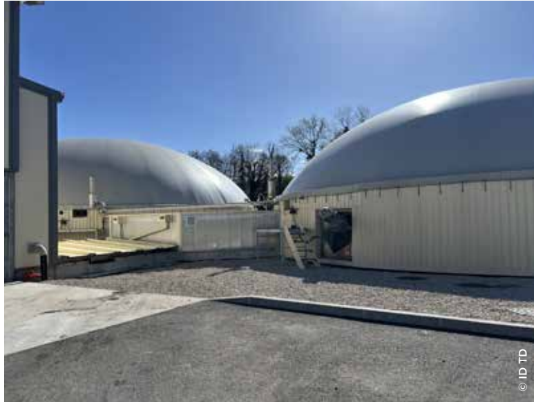
▲ Site de production de biogaz.
